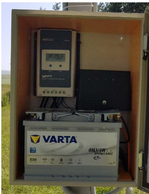
*Рисунок 2. Монтажный ящик с активным оборудованием – контроллер заряда, LTE роутер Huawei B310s, AGM аккумулятор Varta 12В 70А/ч.*
